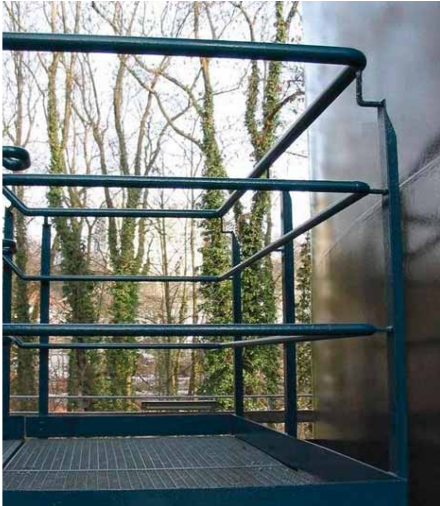
Bild 14 Podestgeländer mit einem abgesetzten Handlauf. Der Freiraum zwischen Handlauf und angrenzender Wandung beträgt mindestens 100 mm.
