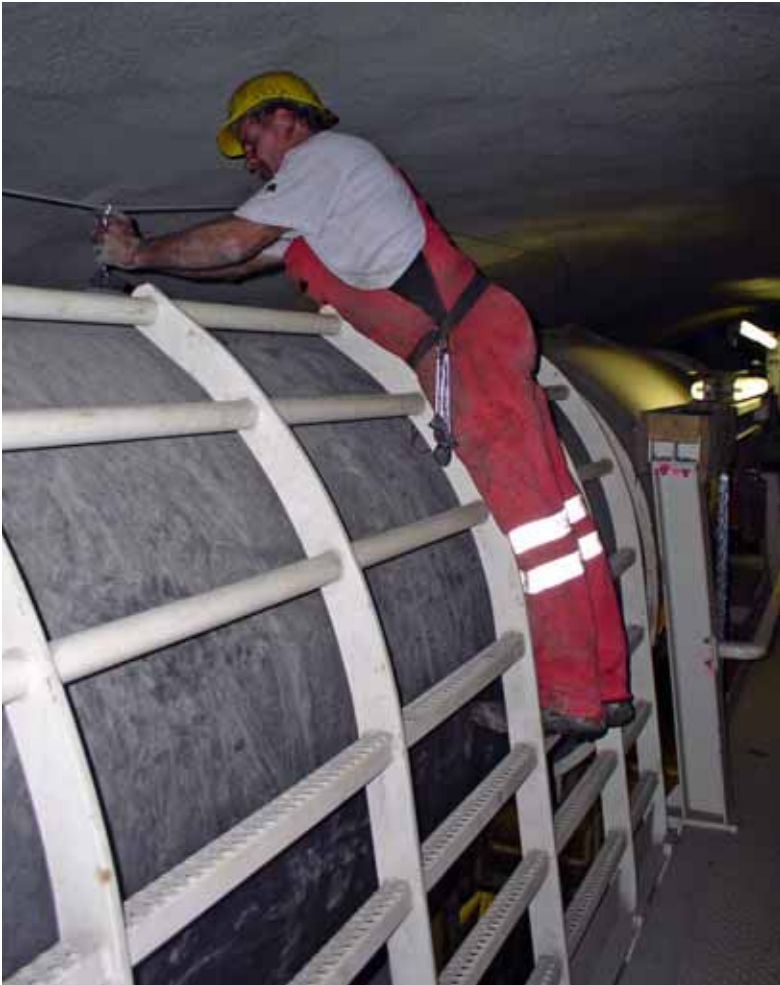
Bild 12 Arbeiten über ein Geländer hinweg. Die Gestaltung des Geländers und insbesondere dessen Höhe entsprechen den besonderen sicherheitstechnischen und betrieblichen Erfordernissen.
