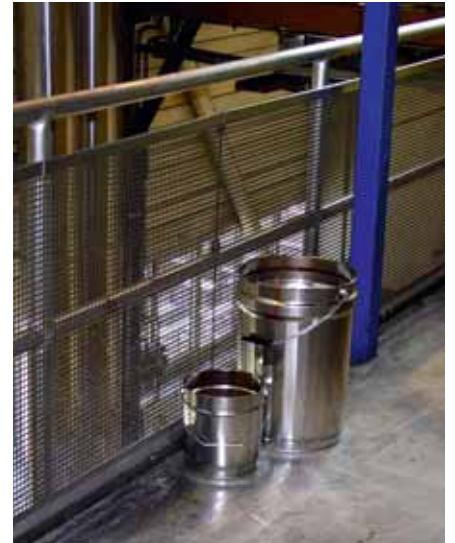
Bild 17 Das zusätzlich angebrachte, vollflächige Gitter verhindert wirksam den Absturz von Gegenständen und Personen.
