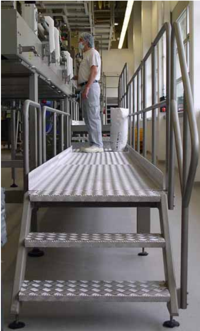
Bild 4 Die Kontrollbühne entlang einer automatischen Verarbeitungsanlage ist beidseitig mit einem Geländer gesichert. Geländer sind erforderlich, weil die Absturzhöhe mehr als 500 mm beträgt.
