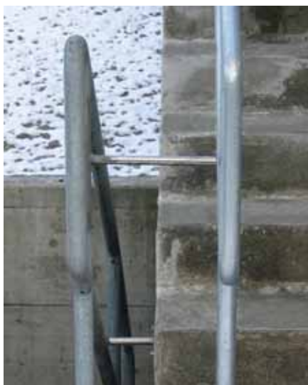
Bild 14 Podestgeländer mit einem abgesetzten Handlauf. Der Freiraum zwischen Handlauf und angrenzender Wandung beträgt mindestens 100 mm.
