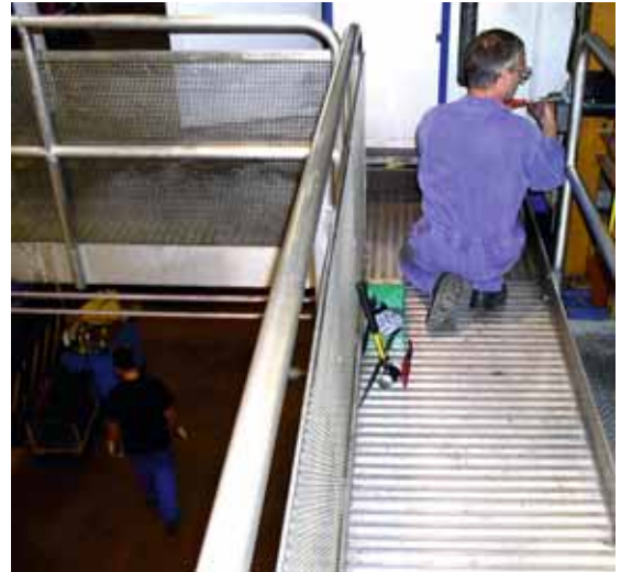
Bild 20 Geländer entlang einer Arbeitsbühne mit Fussleisten und einer vollflächigen Füllung auf der Absturzseite. Dadurch wird verhindert, dass kauernde Personen oder Gegenstände auf den darunterliegenden Verkehrsweg abstürzen.
