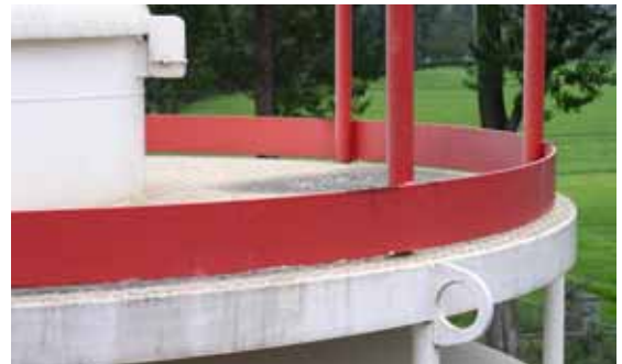
Bild 21 Durch den Zwischenraum zwischen Laufebene und Fussleiste kann Regen- und Schmelzwasser abfließen. Der Zwischenraum beträgt nicht mehr als 10 mm.
