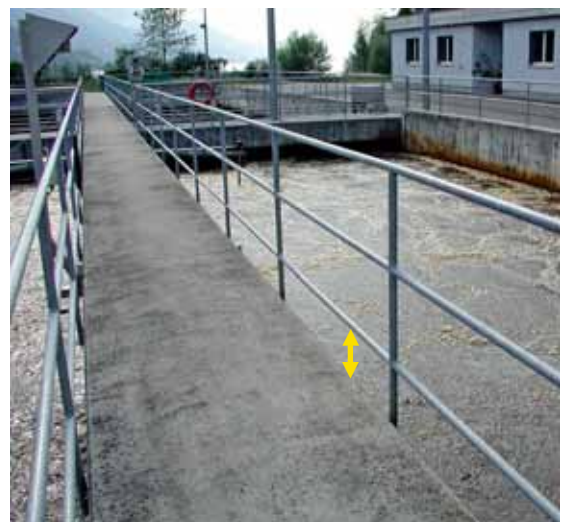
Bild 21 Durch den Zwischenraum zwischen Laufebene und Fussleiste kann Regen- und Schmelzwasser abfließen. Der Zwischenraum beträgt nicht mehr als 10 mm.
