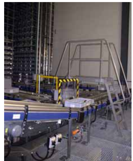
Bild 6 Übergangsbrücke mit beidseitigem Geländer. Der Absturz von Personen und Gegenständen auf die automatische Fördereinrichtung wird wirksam verhindert. Die Treppenleitern weisen ebenfalls beidseitig einen Handlauf auf.
