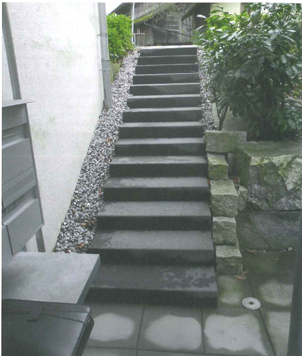
Hier fehlen Handläufe. Sie erhöhen die Sicherheit beim Treppengehen.
